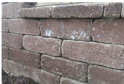
Vápenný výkvet na plote
